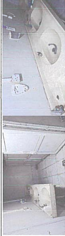
تبدیل تانکی، تبدیل خلاط و خرطوم و کروم
